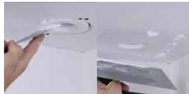
-Cubre los huecos con enjarre/revoque/mancillado y limpia la superficie
