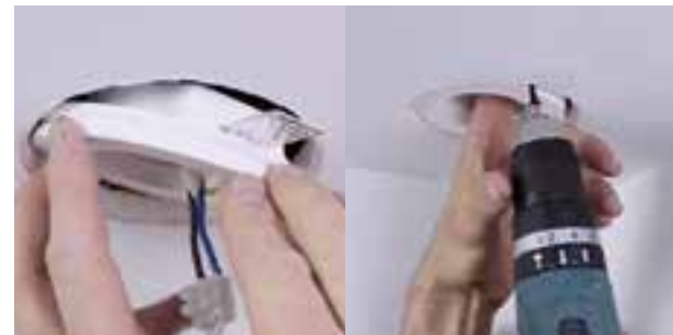
-Introduce el luminario y sujétalo con pijas
