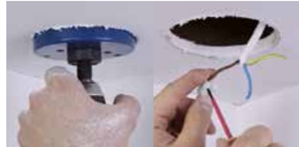
-Realiza el corte en tu falso plafón y conecta el luminario
